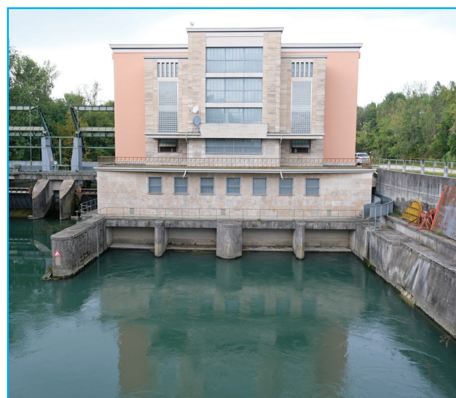
La centrale idroelettrica di Silea (foto: Kallerna)
